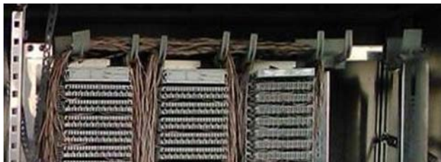
Abbildung 41: Drahtführungsbügel/Rangierösen – waagrechte Führung
